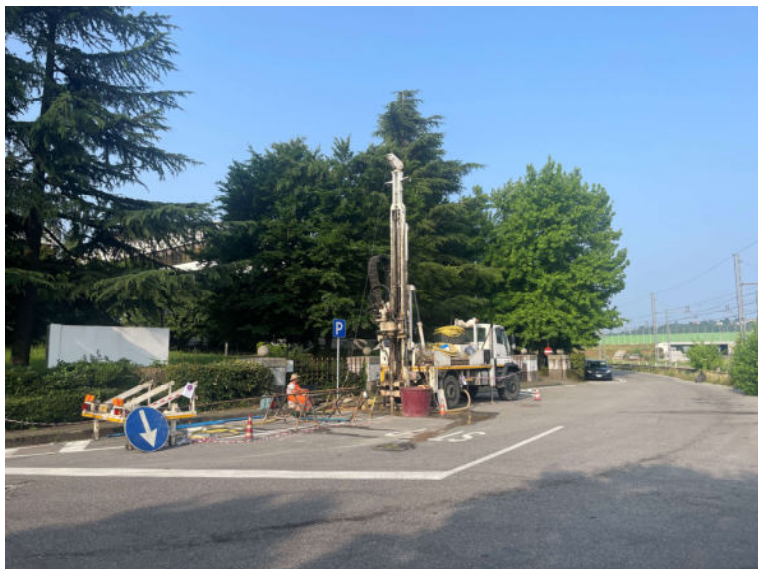
SONDAGGIO S7 – postazione
