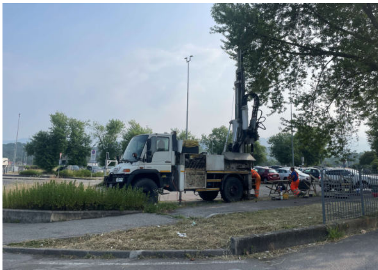
SONDAGGIO S6 - postazione
