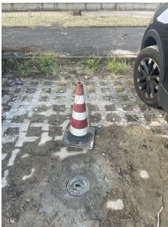
Completamento testa tubazione con chiusino
