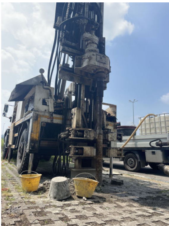
Particolare esecuzione sondaggio
