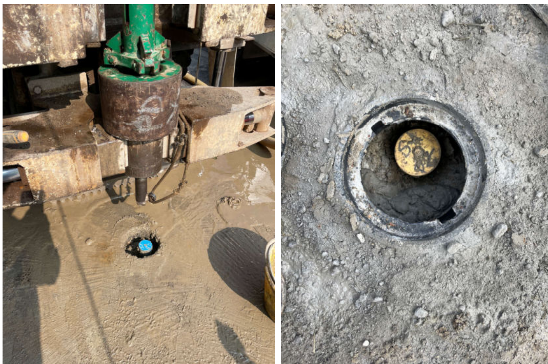
Particolare tubo piezometrico
